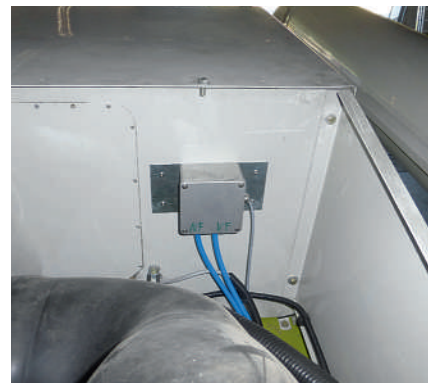
Differenzdrucksensor nimmt Messwerte auf und leitet sie zur Messbox.
